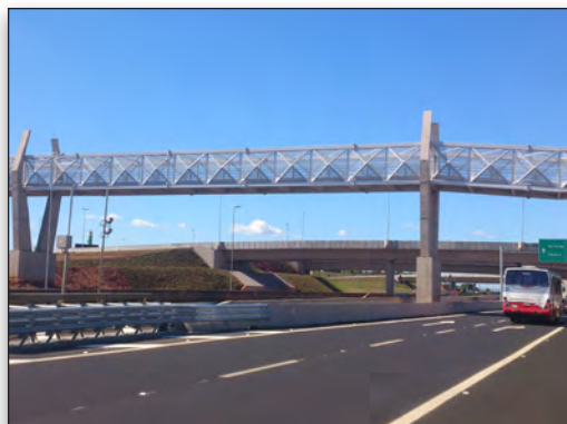
O RM Bridge foi usado para projetar a passarela, de 440 metros de extensão do complexo viário, destinada a pedestres e ciclistas.
