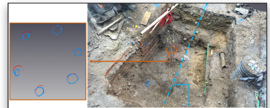
Vodorovný řez armovacími tyčemi znázorňující přesné porovnání fotogrammetrie s terestriálním laserovým skenováním (TLS): modré kružnice představují fotogrammetrii, zatímco červené kružnice představují TLS; maximální odchylka činí ~6-10 milimetrů.
