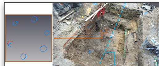
Taglio orizzontale delle armature che permette di confrontare con cura la fotogrammetria e la scansione laser terrestre (TLS): i cerchi blu rappresentano la fotogrammetria e i cerchi rossi rappresentano la scansione TLS; la deviazione massima è di circa 6-10 millimetri.
