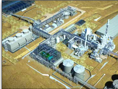
Ce projet de 245 millions de dollars comprend une usine produisant 1 400 tonnes d'acide par jour, ainsi qu'un système de production d'électricité à partir de chaleur résiduelle avec une unité de turbine à vapeur.
