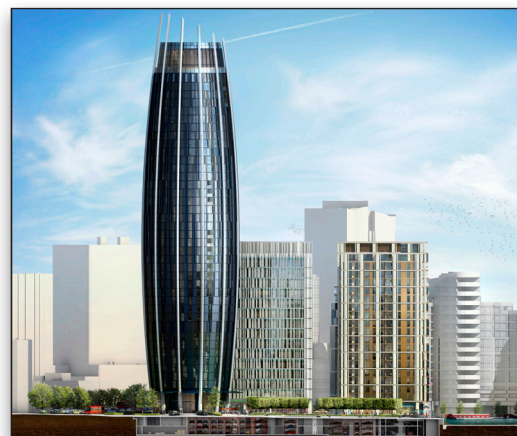
В основании башни находится бутик-отель с 93 номерами, выше идут 209 квартир и бар под открытым небом. Корпус 1 установит новый стандарт для жилых зданий в Паддингтоне.
