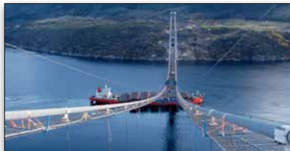
Ponte Hardanger na Noruega, pela Statens Vegvesen.
