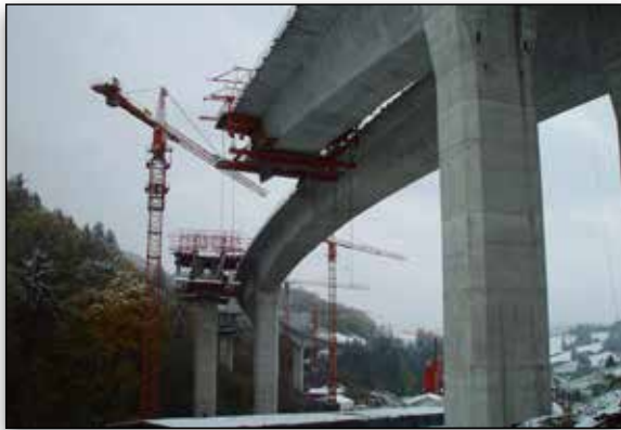
Viaduto Petelinjek, Eslovênia por GRADIS, Eslovênia.
