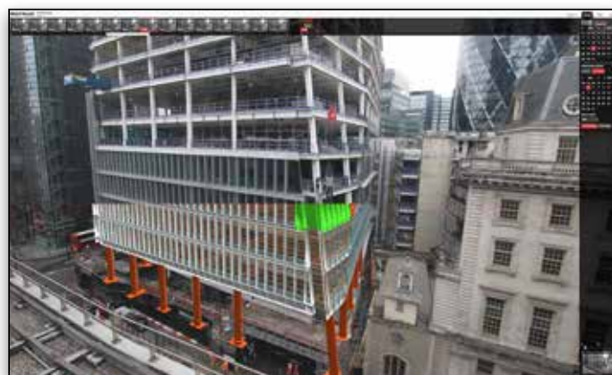
SYNCHRO Pro 提升项目施工全过程管理中的 4D 数字化信息应用。
