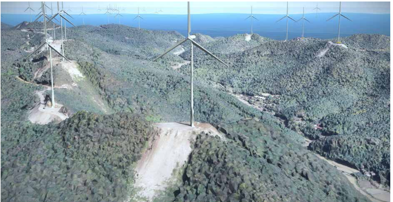
麻城市蔡家寨风电场地貌三维工程级别模型，由湖北省电力勘测设计院有限公司供图
