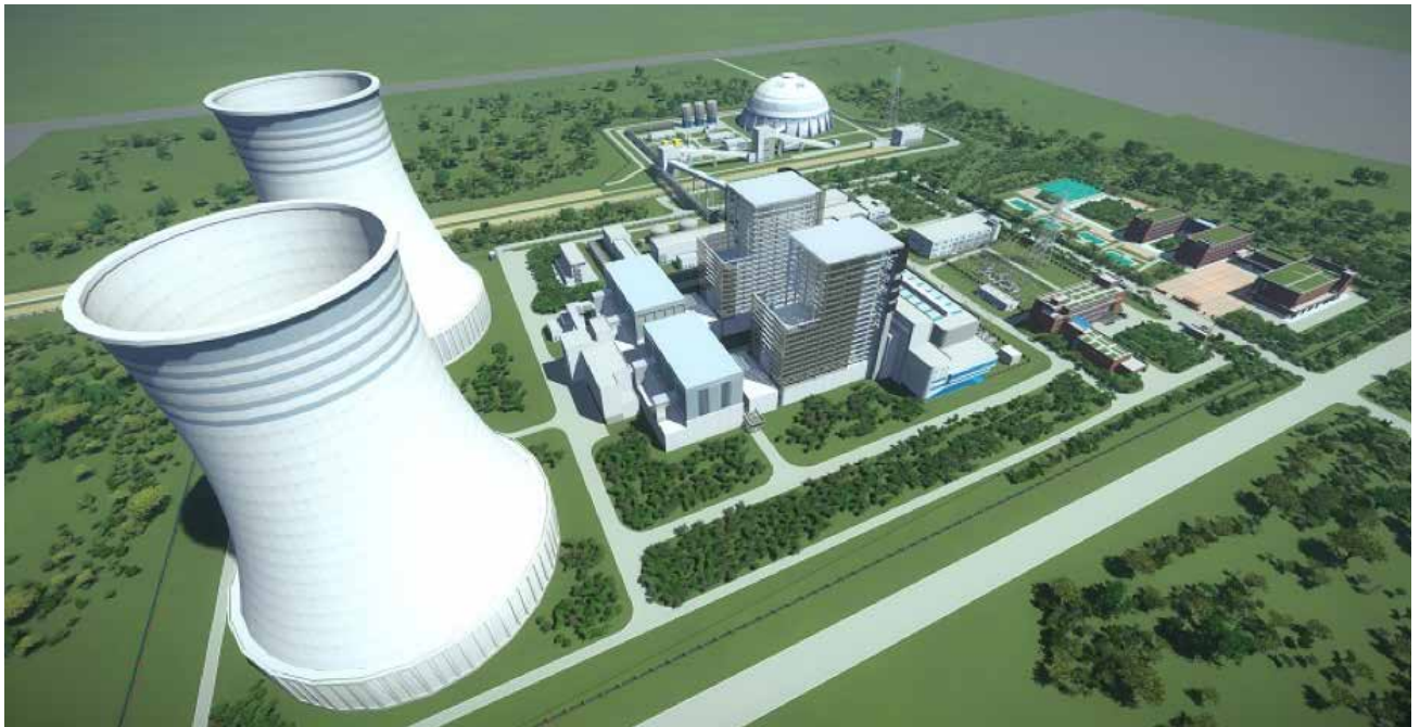
神华神东电力富平热电厂工程，由中国电力工程顾问集团西北电力设计院有限公司供图
